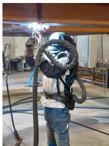
Figure 3 – Photographie d'opérations de soudage
