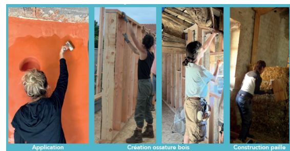
Figure 1 : formation au divers métiers de l'écoconstruction sur chantiers-écoles Oïkos.
