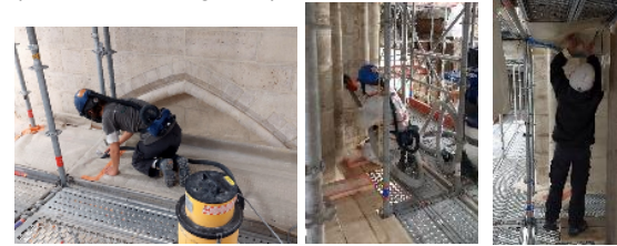
Figure 10: exemples de situations de travail observées (aspiration du sol, aspiration des verticaux, pose de protections sur l'échafaudage).
