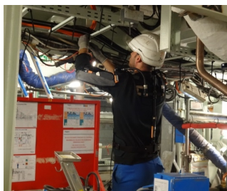
Figure 5 – Photographie de passage de câbles par un électricien
